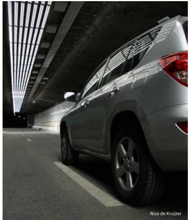
Zes rijen ledarmaturen met tegenstraalverlichting die alleen in de ingangzone worden gebruikt. Geheel links een rij die door de gehele tunnel loopt.
