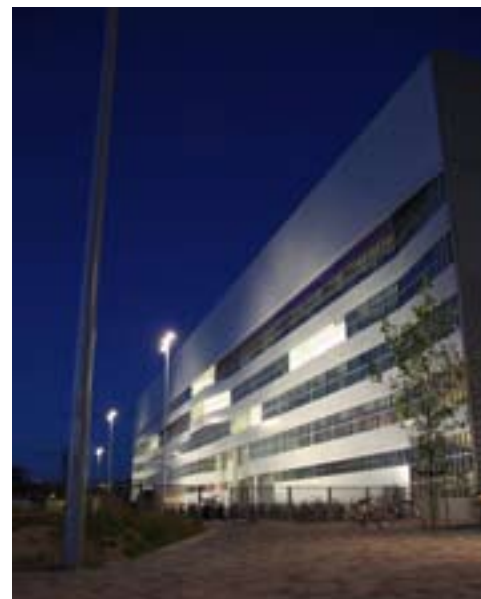
De gevel van het FNWI-gebouw in Amsterdam.
